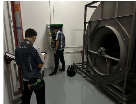
รูปที่ 2.11 ตรวจเช็คพัดลมอัดอากาศ
