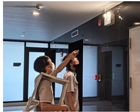
รูปที่ 2.2 ตรวจสอบระบบไฟฟ้าฉุกเฉิน (Emergency Light)
