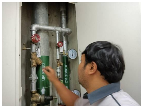
รูปที่ 2.22 ตรวจสอบระบบน้ำประปา
