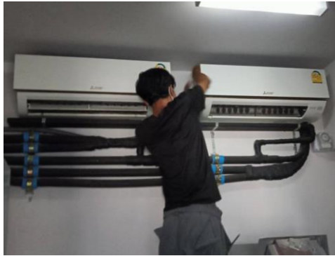
รูปที่ 2.1 ทำความสะอาดเครื่องปรับอากาศ
