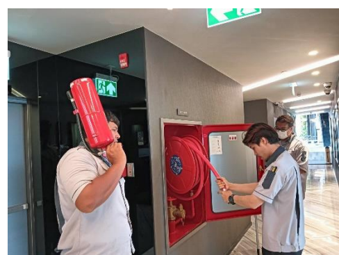
รูปที่ 2.3 ตรวจสอบอุปกรณ์ดับเพลิง
